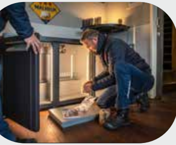
UITPAKKEN EN MONTEREN. DE GATEN WORDEN LUCHTDICHT GEMAAKT, DE SCHAPPEN IN DE KOELING GEPLAATST, WE TESTEN OF DE KOELING GOED WERKT.
